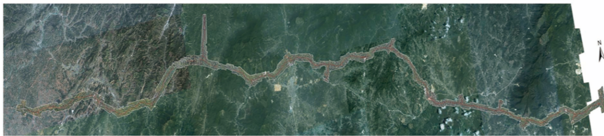
江门至罗定高速公路沿线航拍图
