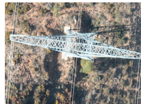
基于无人机航拍影像进行电力巡线
