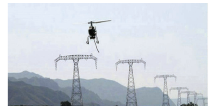
基于直升机进行电力架线
